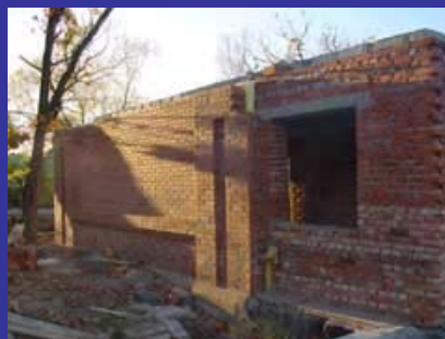
Строительство Центра реабилитации во Владивостоке, сентябрь 2005
